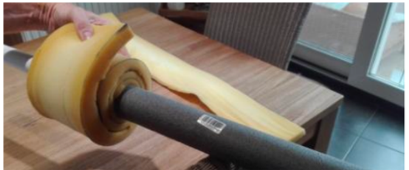
Figuur 4: Het wikkelen van een moussereep rond de PVC-buis met buisisolatie
